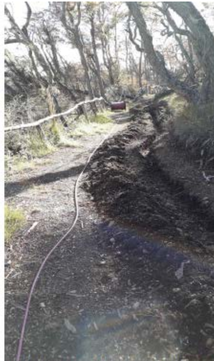
Ilustración 3: Desenrollo del cable subterráneo troncal
