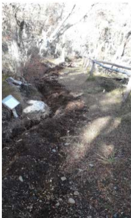
Ilustración 2: Soterramiento del tendido eléctrico en zona de bosque
