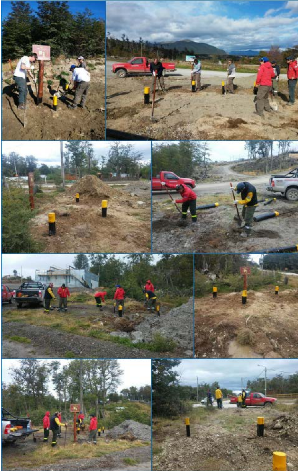
Imagen 4. Panel fotográfico de acondicionamiento de carteles en puntos de agua (tanques soterrados) y protección con postes.
